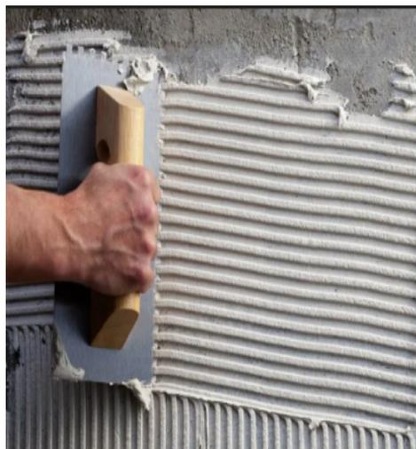
3. 2. Com um rolo de textura aplique a argamassa de forma que fique uniforme e crie ranhuras na argamassa para melhor aderência das pedras. Aguarde 24 horas para seguir com o processo de assentamento das pedras
